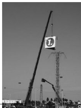
Démontage d'une enseigne illégale
