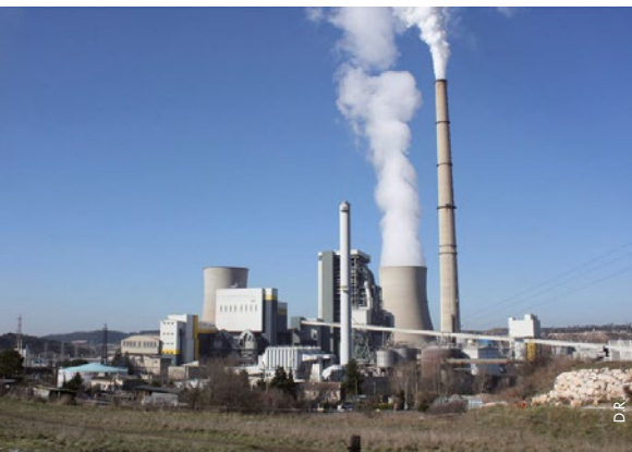
Centrale Thermique de Gardanne
