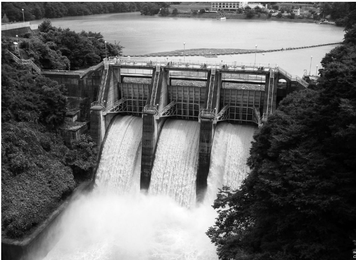
▲ Relier deux barrages proches de niveau différents, permet de remonter de l'eau quand la production électrique est excédentaire et d'en produire quand il en manque en laissant l'eau chuter.
