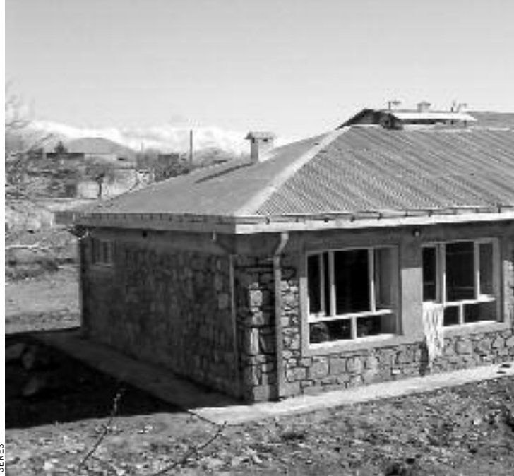
Construction d'écoles bioclimatiques en Afghanistan.
