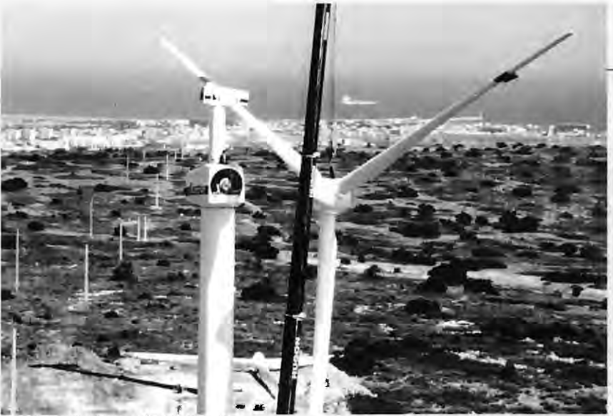
Installation d'éoliennes à Port-la-Nouvelle.
