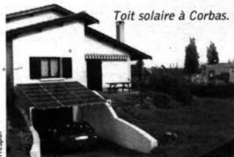
Toit solaire à Corbas.
