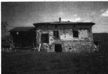
A l'origine, une maison en très mauvais état.
