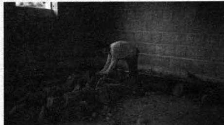
Pose d'un hérisson de pierres.
