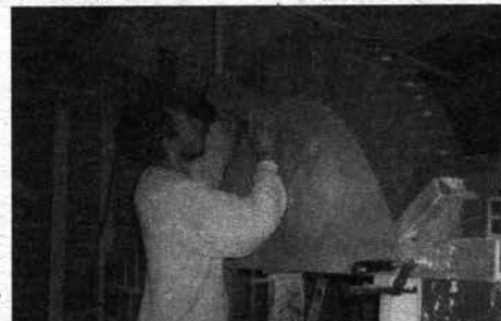
Construction des cloisons intérieures.
