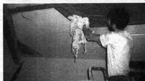
Rembourage des combles avec de la laine.
