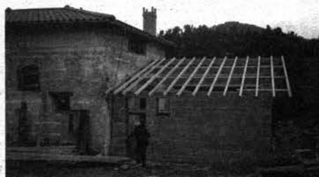
Charpente sur la partie neuve.
