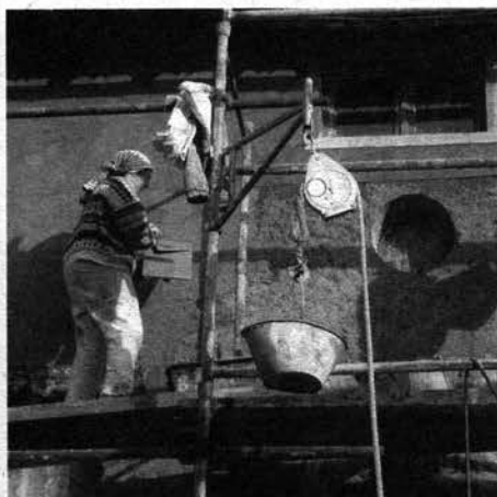
Réalisation du crépis extérieur.
