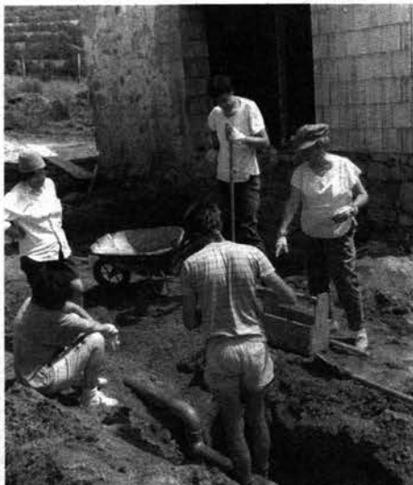
Pose du chauffage à air par le sol.
