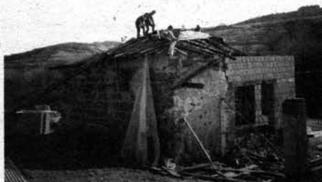
Réhaussement et restauration de la charpente.
