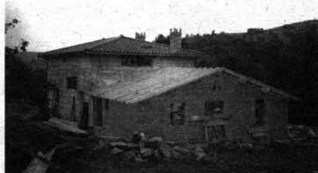
Extension en briques isolantes.
