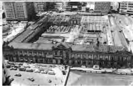
Restauration du marché public.
