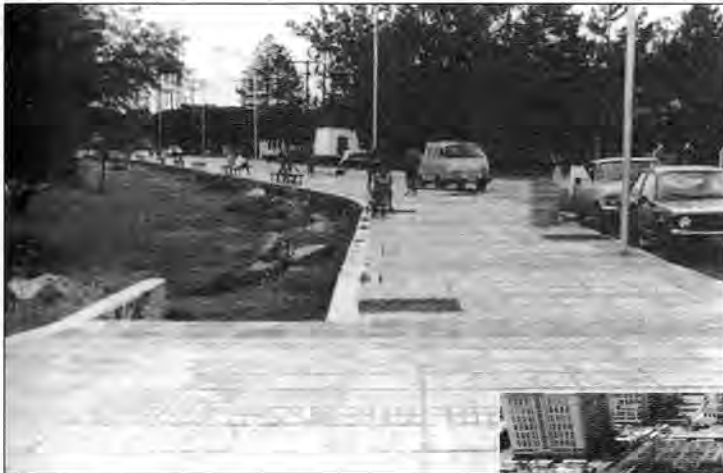
Collecte d'égout et réalisation d'un trottoir.
