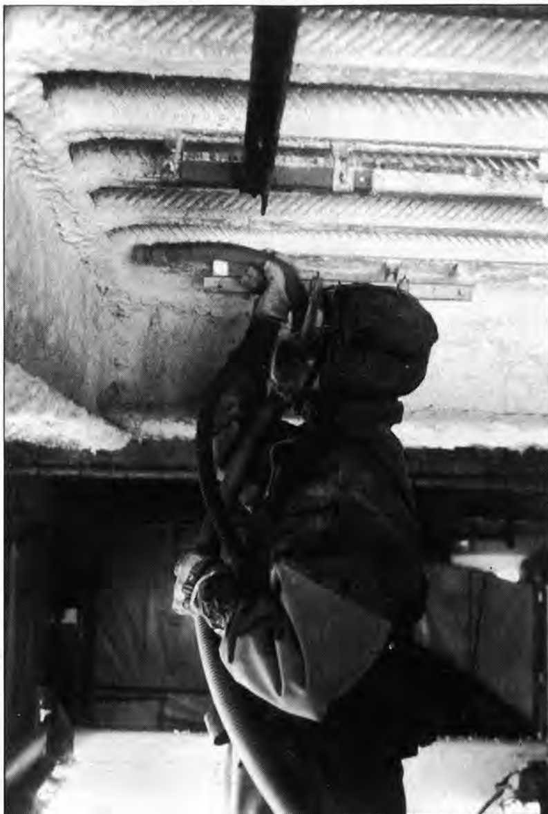
Opération de nettoyage de l'amiante : de multiples précautions doivent être prises (photo TI-France)
