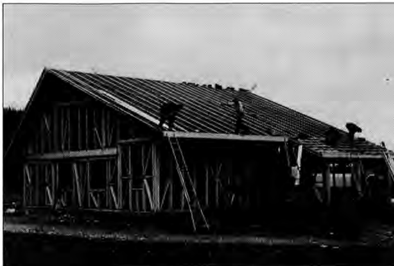
Chantier collectif : le travail en groupe permet de construire des maisons de A à Z et de très bonne qualité (photo Castors)
