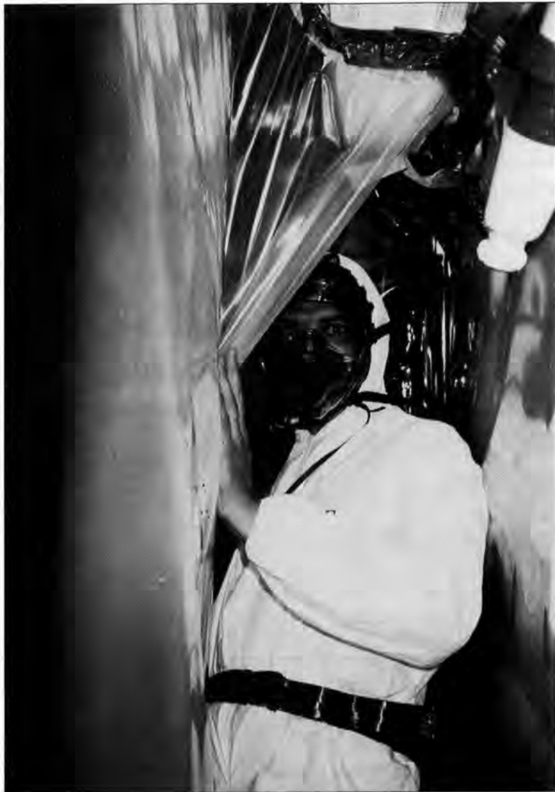
Désamiantage : pour éviter la dispersion des poussières, tout le bâtiment nettoyé doit être soigneusement enveloppé (photo Association Française de l'Amiante)
