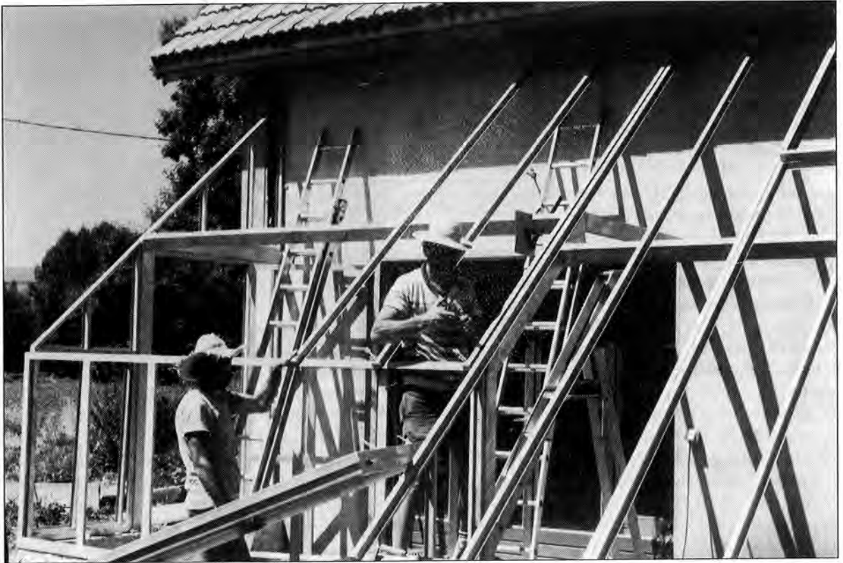
Construction d'une serre : les adeptes de l'autoconstruction sont de plus en plus souvent également des adeptes des énergies renouvelables (photo Castors)
