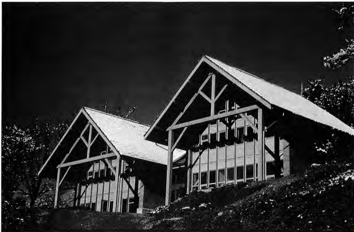
La maison bleue vue de face. Elle abrite les locaux de la Maison d'Édition, de la revue, l'administration du Centre et des salles de formation. En couverture de ce numéro, on peut la voir de l'autre côté avec ses murs nord courbes (photos Terre Vivante)
