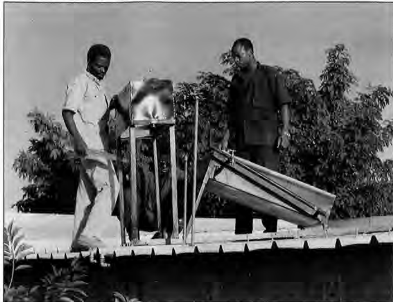
Ouagadougou : montage d'un capteur solaire pour l'eau chaude.
