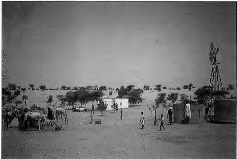
En haut : construction de l'éolienne sur place. Au milieu : installation de l'éolienne par les habitants. En bas : l'un des cent villages ayant une pompe à eau éolienne.
