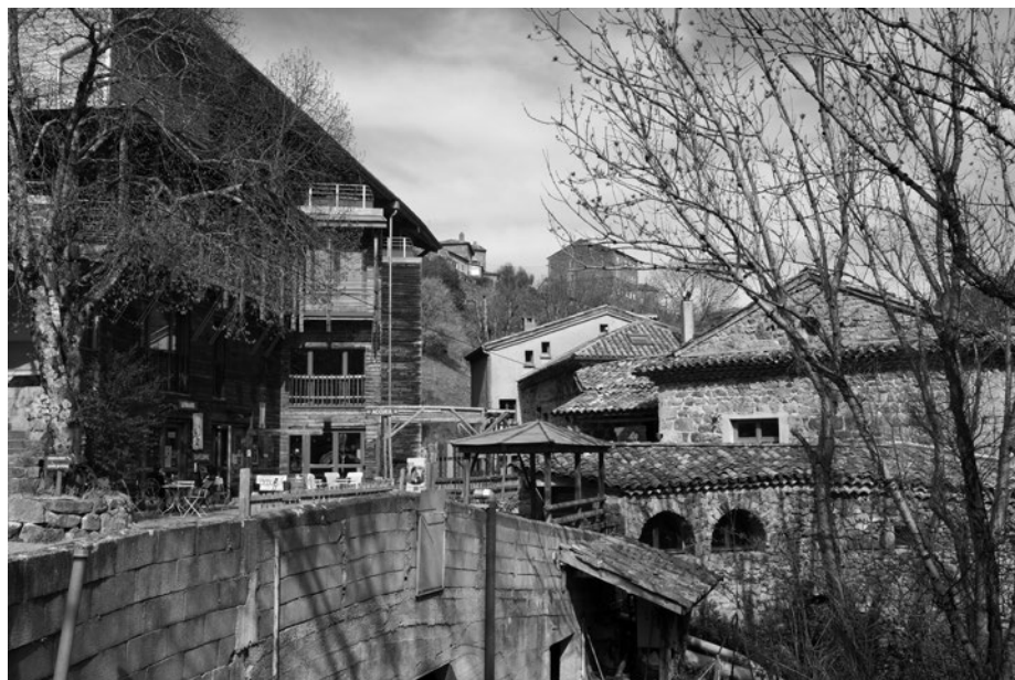
Ardelaine est installée dans une ancienne usine de tissage comprenant de nombreux bâtiments en pierres. Des extensions en ossature bois ont permis de suivre l'évolution de l'entreprise.
