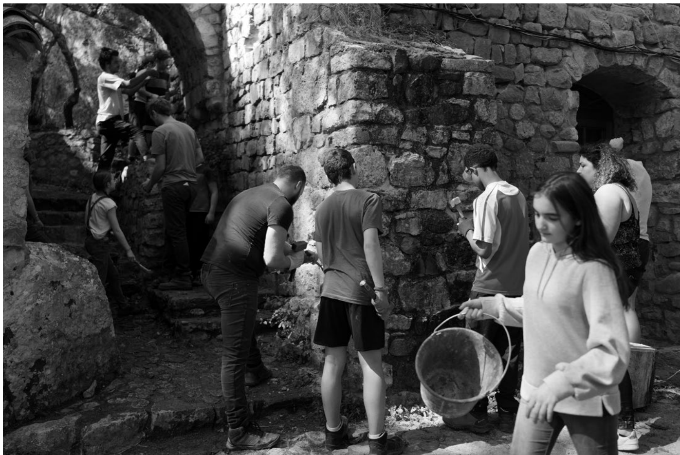
Chantier d'ados en train de refaire les joints d'un bâtiment de l'écovillage.
