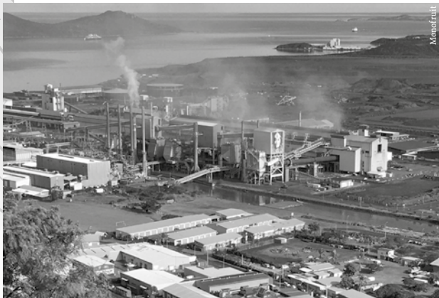
Usine SLN de Doniambo à Nouméa, qui traite le nickel.
