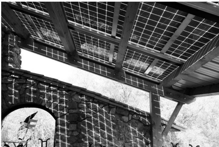
Une des terrasses recouverte de photopiles.
