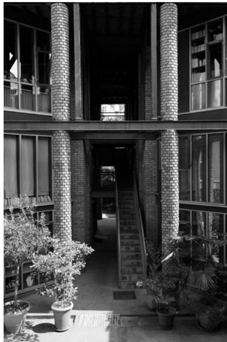
Tous les appartements donnent sur une rue intérieure.
