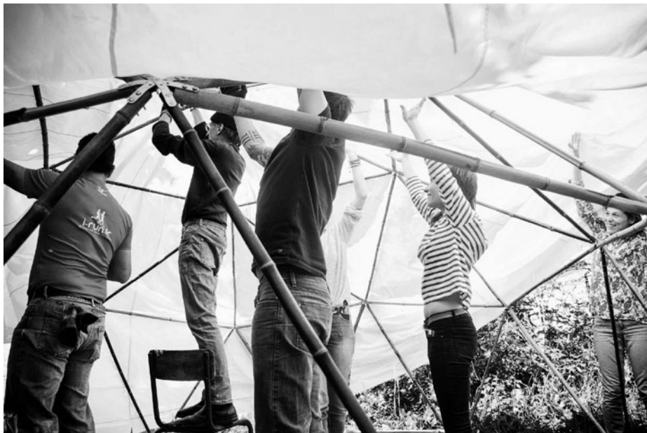
Chantier collectif de construction d'un dôme géodésique animé par La Manufacturette.
