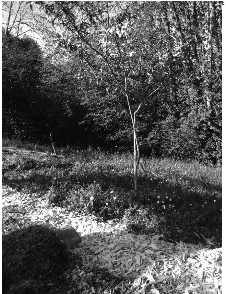
Le filtre à broyats de bois est un système d'assainissement des eaux ménagères dans des tranchées de faible profondeur remplies de broyat de bois et alimentées en alternance. L'Écocentre Pierre et Terre, dans le Gers, développe, entre autres, ce procédé simple à mettre en place mais dont le développement est freiné par une législation inadaptée. Écocentre Pierre et Terre, Route de Saint-Mont, 32400 Riscle.
