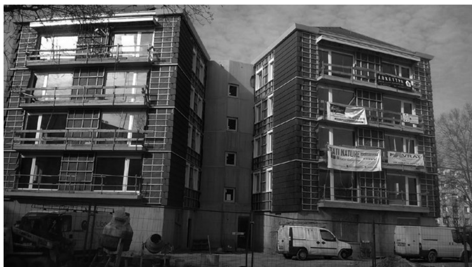
Chamarel en chantier en mars 2017 à Vaulx-en-Velin.
