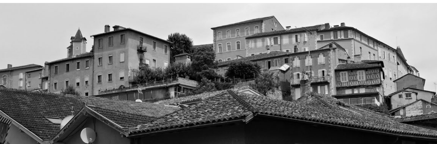
La Convention vue depuis le bas d'Auch : un bâtiment se trouve derrière la partie arborée (les terrasses), un autre se trouve à gauche, un autre sous les terrasses.
