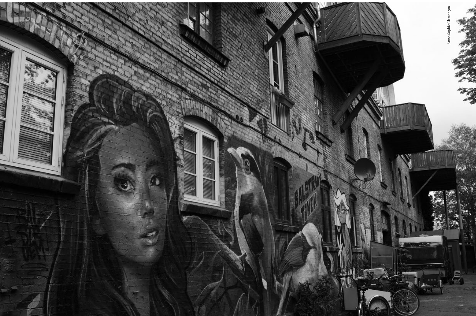
Street art sur un ancien bâtiment de la caserne restauré avec ajout de balcons en bois.
