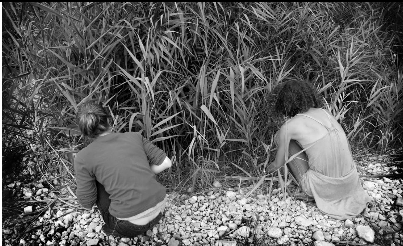
▲ Chantier pour la mise en place d'un système de phytoépuration des eaux avec filtre à roseaux en contrebas des bâtiments.
