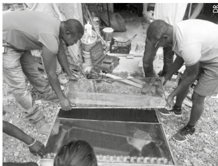
Construction d'un panneau solaire thermique pour permettre à des exilées du Briançonnais de se doucher à l'eau chaude.
