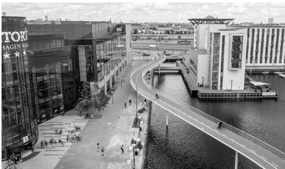
▲ Depuis quelques années, la municipalité de Copenhague a mis en place des véloroutes ("red road") totalement indépendantes de la voirie ordinaire, parfois comme ici en surplombant le port.
