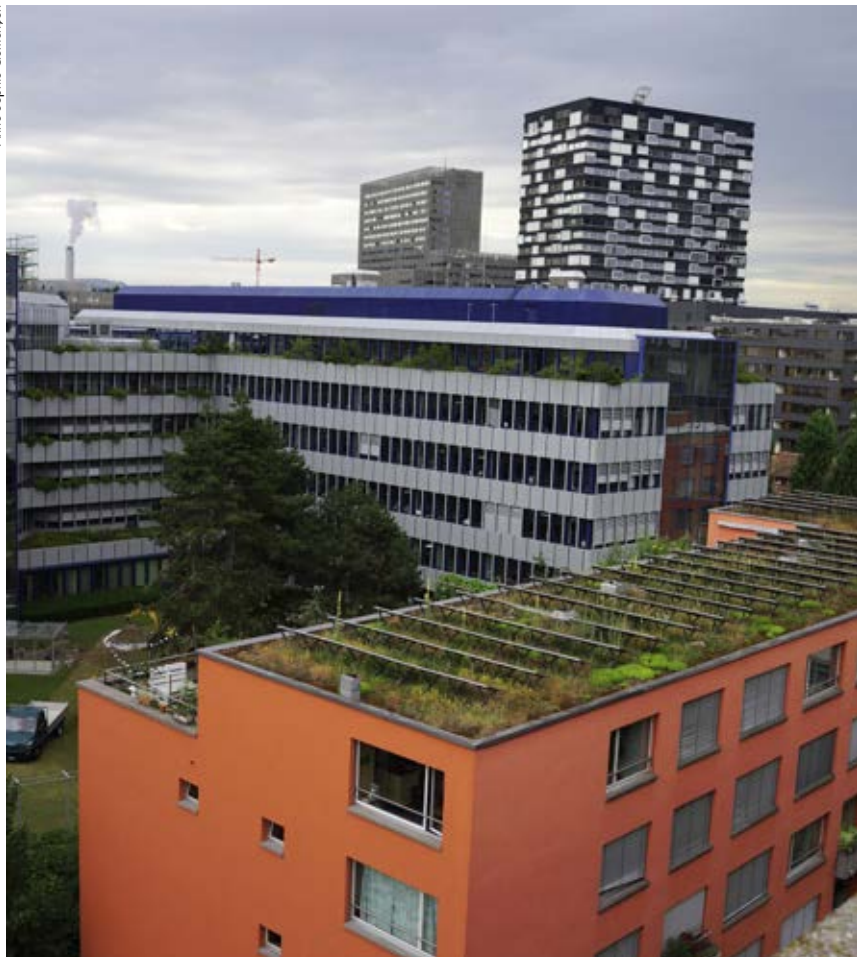
▲ Sur les toits des deux petits immeubles de Hardturm, des photopiles assurent une partie de la consommation électrique.
