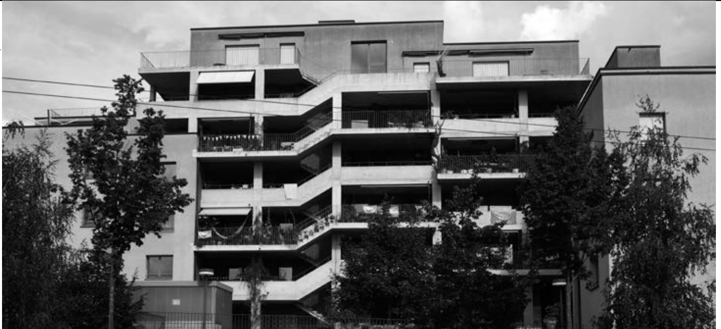
▲ Le bâtiment de Heizenholz a été réalisé à partir de deux petits immeubles préexistants. La partie centrale rajoutée a permis la création de nombreuses terrasses communes.
