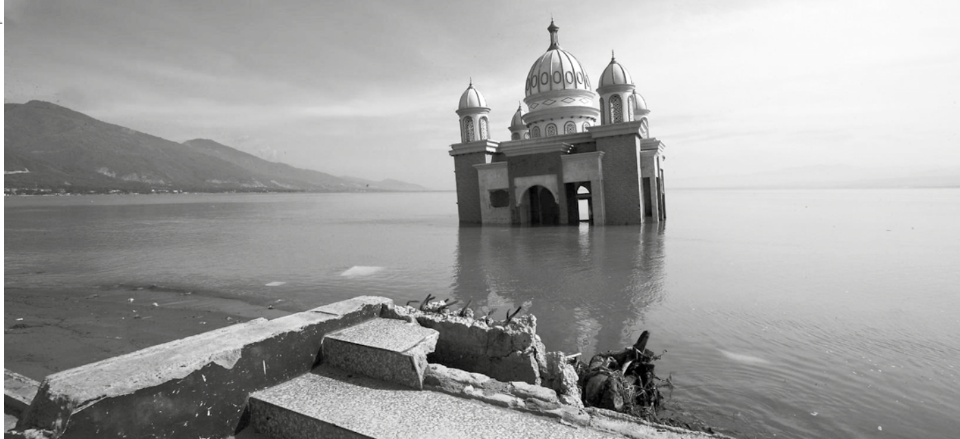
▲ Montée des eaux, symboles architecturaux qui s'écroulent, l'effondrement serait un phénomène sur lequel on n'aurait pas de prise.
