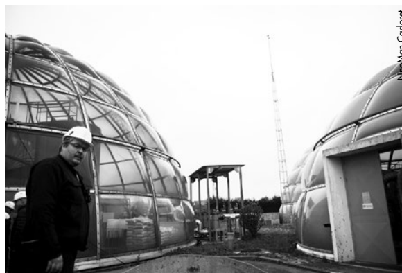
L'usine vue de l'extérieur...
