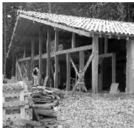
Maison de Caroline en construction.
