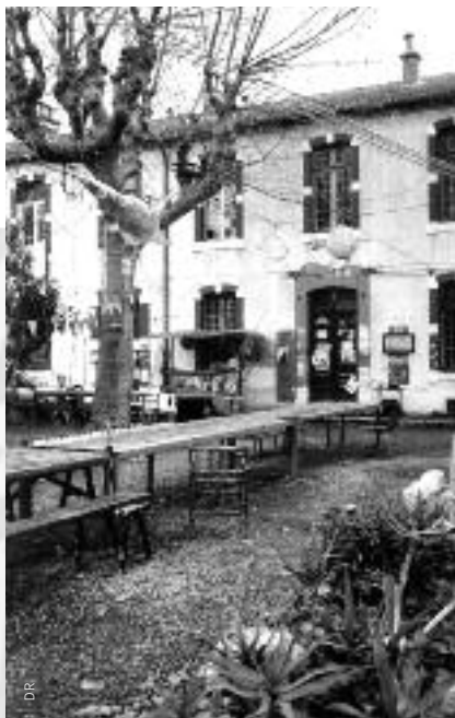
Le squat avant démolition.
